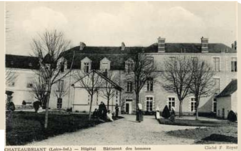
CHATEAUBRIANT (Loire-Inf.) — Hôpital Bâtiment des hommes Clément F. Roper
